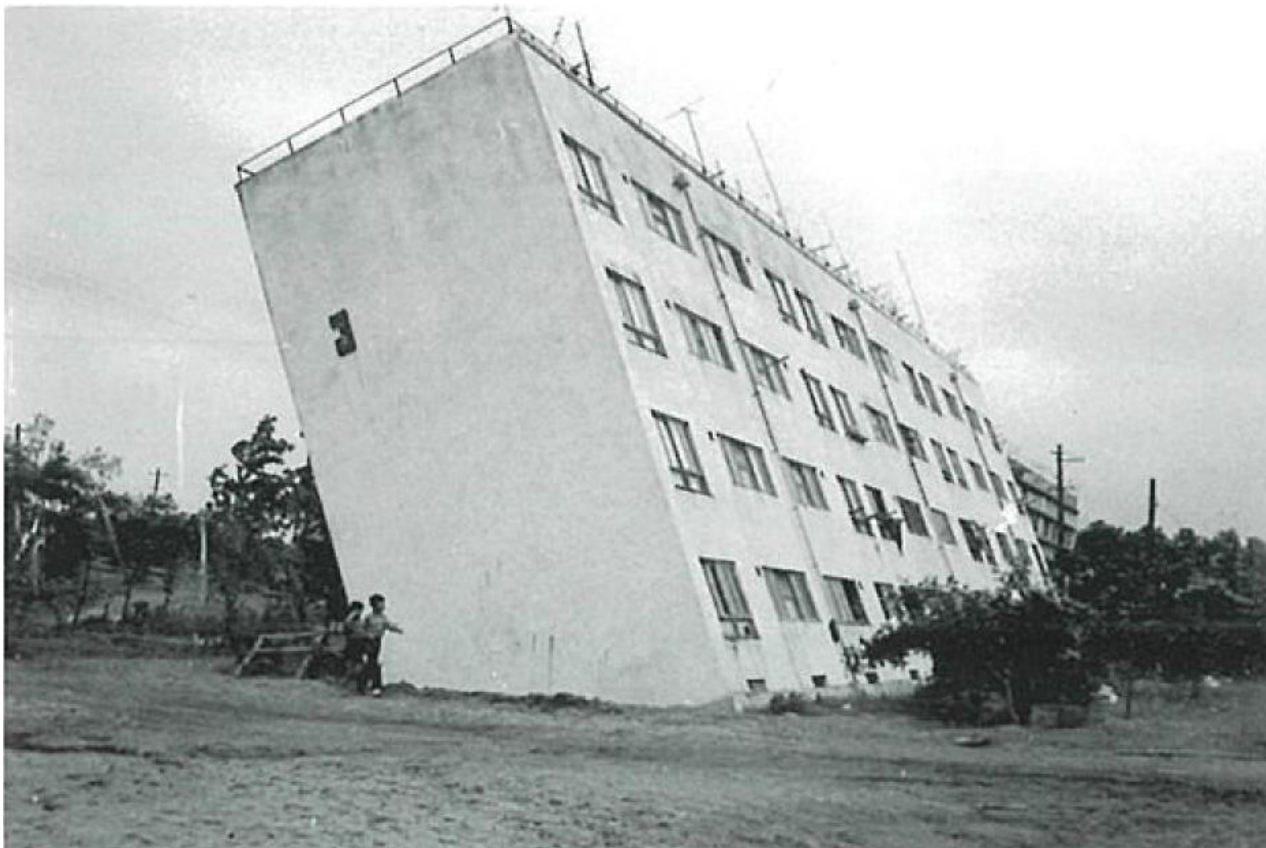
液状化により沈下して大きく傾いたアパート (1964年新潟地震) [早稲田大学提供]
